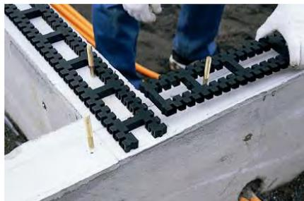
従来の工法では、基礎と土台が接しているため、基礎の湿気が土台に上がりやすく、腐れの原因となっていました。
