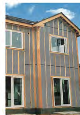
カネライトフォームスーパーEX 外張断熱施工例
